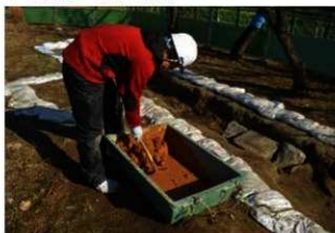
6 修復石材固定用の土の練り上げ
