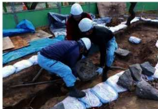
7 礎石の修復作業風景
