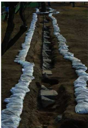
3 第1調査区石列修復完了（北から）
