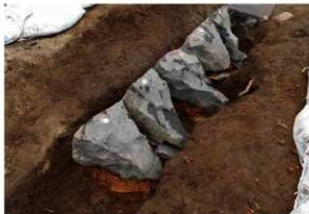
8 地覆石の修復状況
