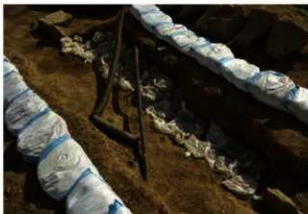
8 石材抜き取り痕跡の養生
