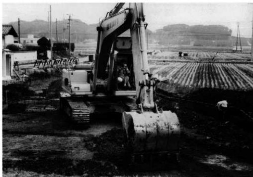
機械による掘削作業
