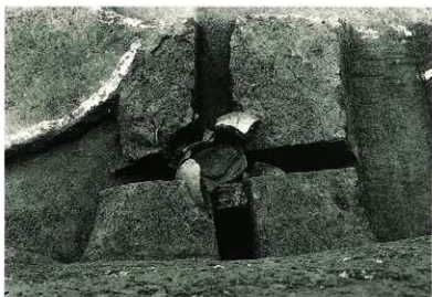
122. SC54カマド（南方向へ） 写真図版77、中段上参照
