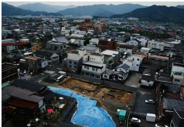
松下家屋敷跡遠景（北から）
