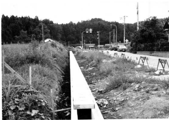
調査前の状況(北から)
