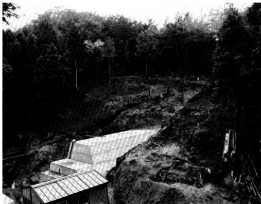
近景 (工事残土除去後)
