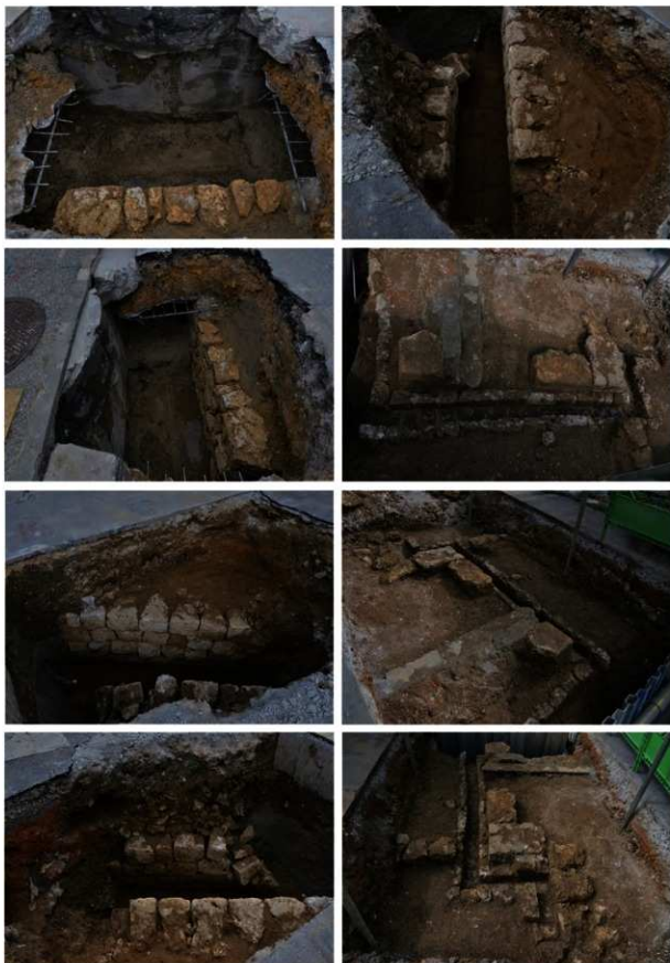
図版 4 調査完了状況
