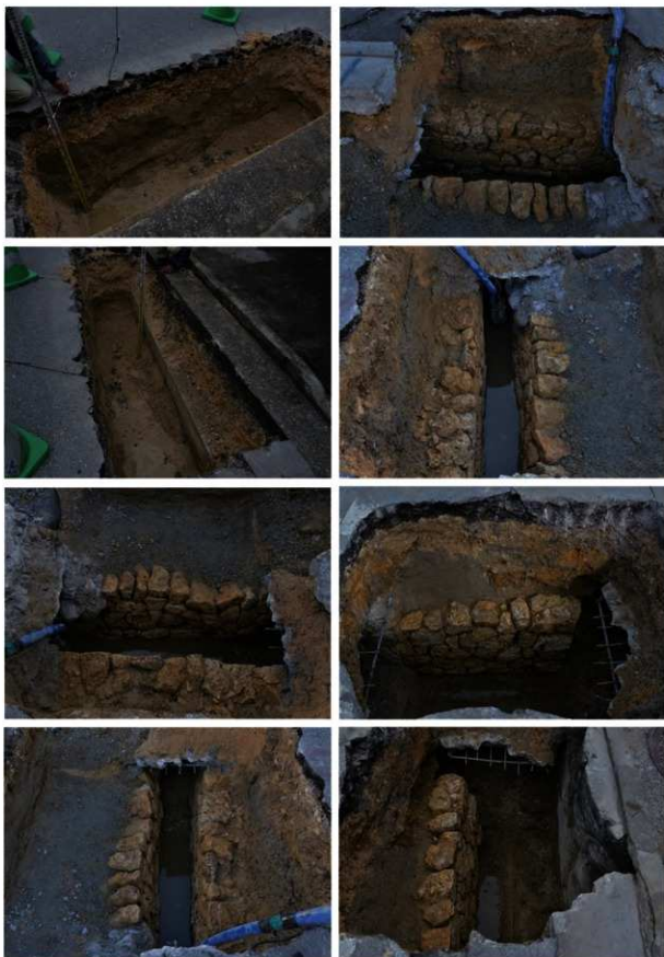
図版3 調査完了状況
