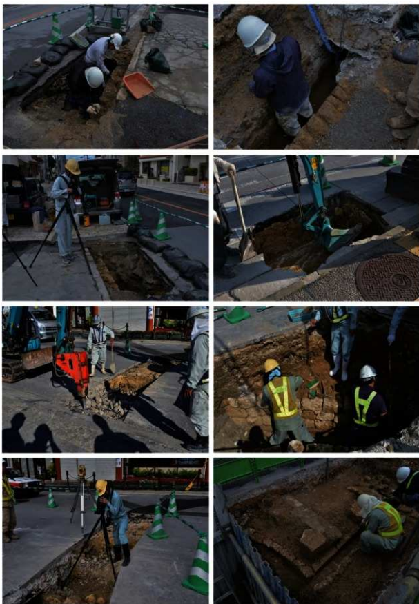
図版 1 遺構検出・記録撮影状況
