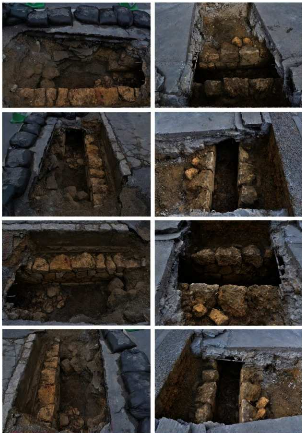
図版2 調査完了状況
