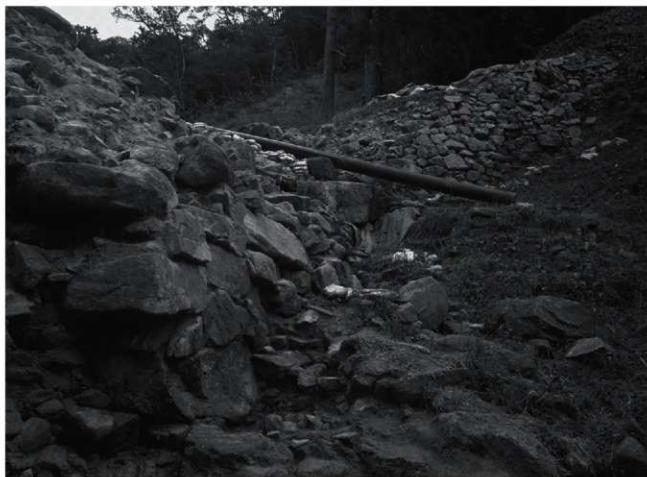
第45-2次調査 大石垣前面状況（南西から）
