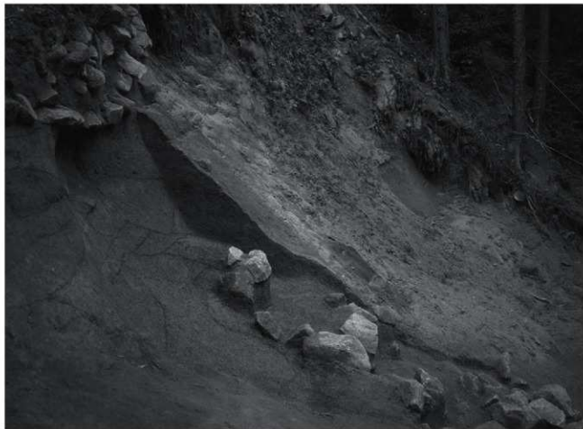
第 48 次調査 崩落部 土層観察 (南から)
