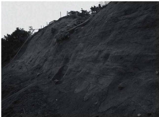
第40次調査 南地区 土塁版築状況（東から）
