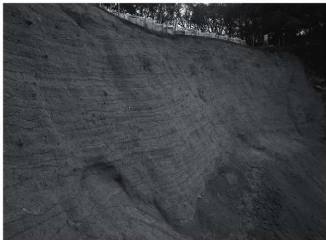
第 40 次調査 北地区 土塁版築状況（南東から）
