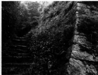
16 座主跡の石垣と登拝路（東院谷 筑紫野市）
