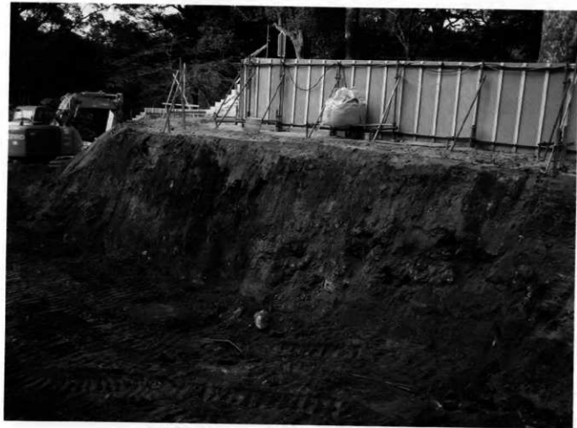
立会調査 (2011年12月20日、南からC壁面を望む)
