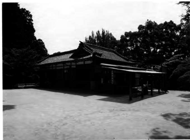
龍門神社社務所遠景 (北東から)
