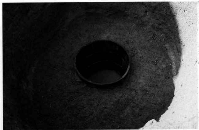
243SE025 1.5m 掘下げ状況 近景 (東から)
