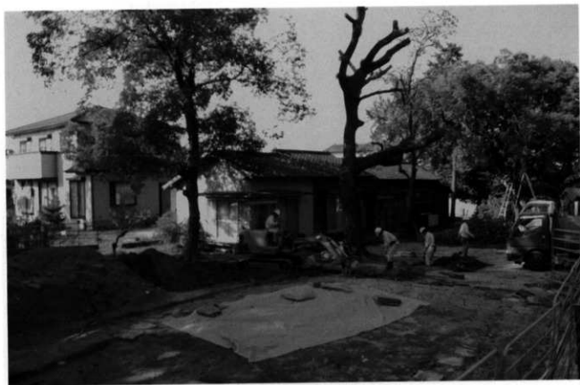
第215次調査1・3区工事状況 (南東から)
