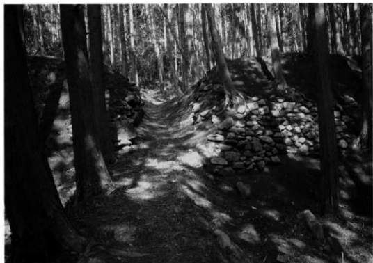
phot.1 SX005.010 遠景 (南から)
