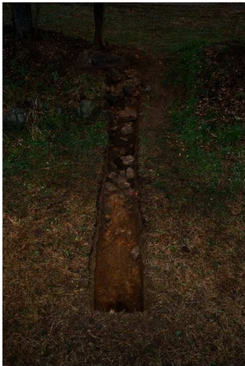
pla.26 12 トレンチ 検出状況 (西から)
