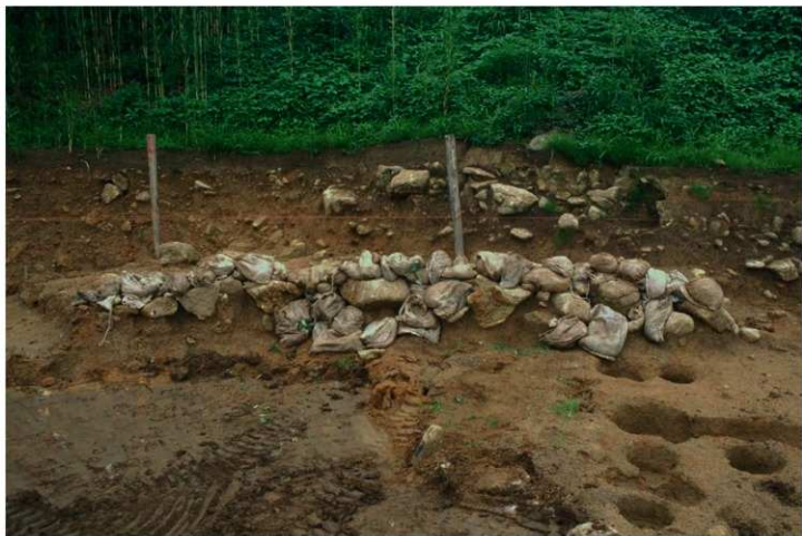
pla.23 40SX015 埋め戻し前、養生（西から）
