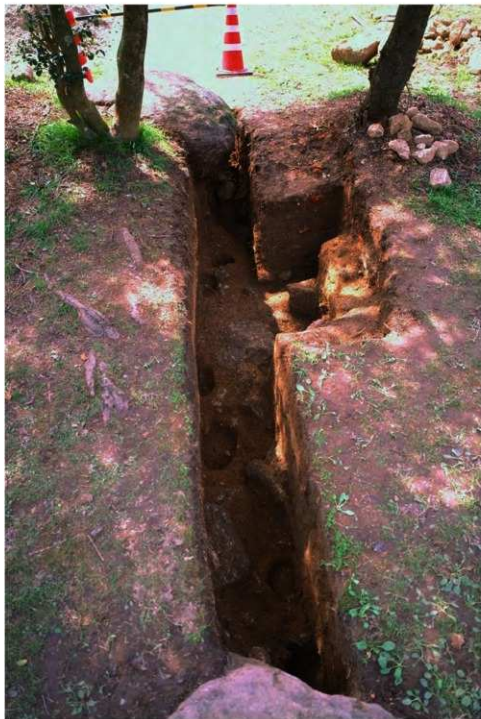
pla.53 14 トレンチ 完掘状況 (東から)
