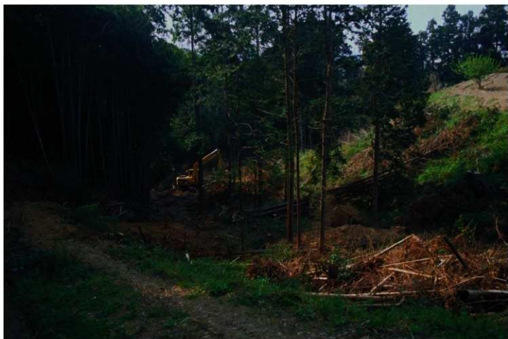
pla.55 表土めくり（東から）
