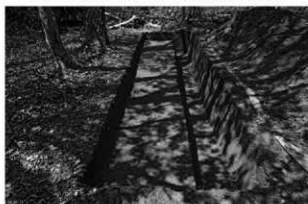
上野山5号墳 第2トレンチ調査後(南から)
