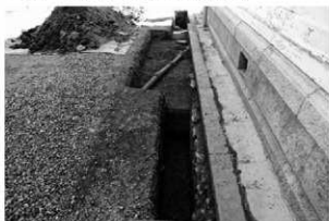
写真4 第2トレンチ調査後(西から)
