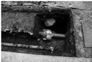
写真1 第1トレンチ深堀(南から)
