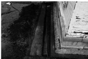
写真16 第8トレンチ調査後(西から)
