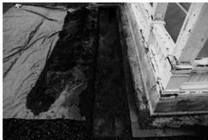
写真7 第3トレンチ調査後(北から)
