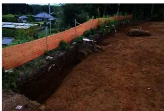
SD005 南西側 南東から
