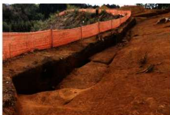
SI024・SD003 全景 北西から
