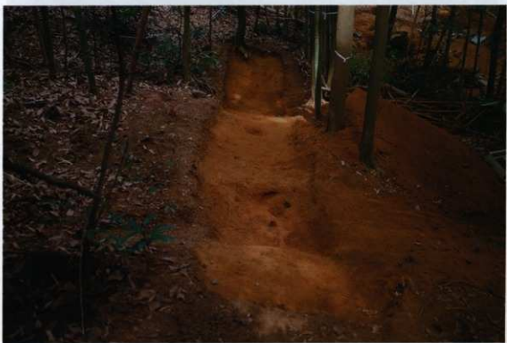
27. 北トレンチ完掘状況（西から）
