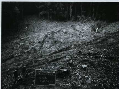
29. 本堤右岸 着工範囲 伐採後状況 （北から）
