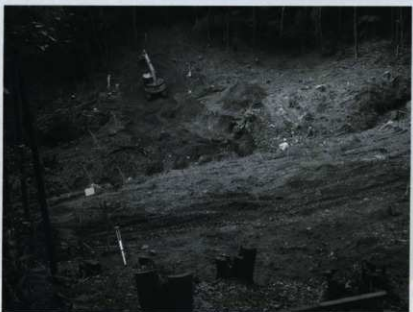
30. 本堤右岸 工事状況 （北から）
