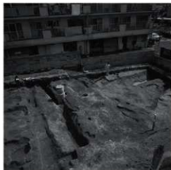
pla2 道路部分全景（南西から）
