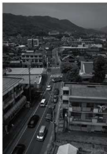
pla1 第 217 次調査区より五条交差点を望む（南から）
