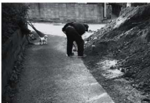
写真6. 立会調査状況 (東から)
