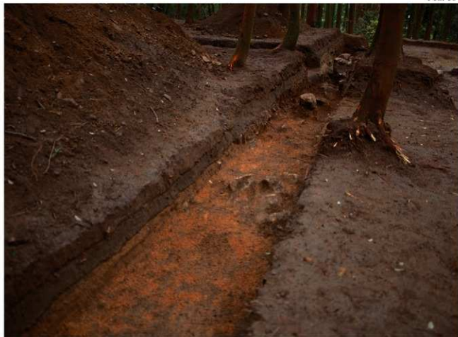
G区北側地盤状況（北西から）
