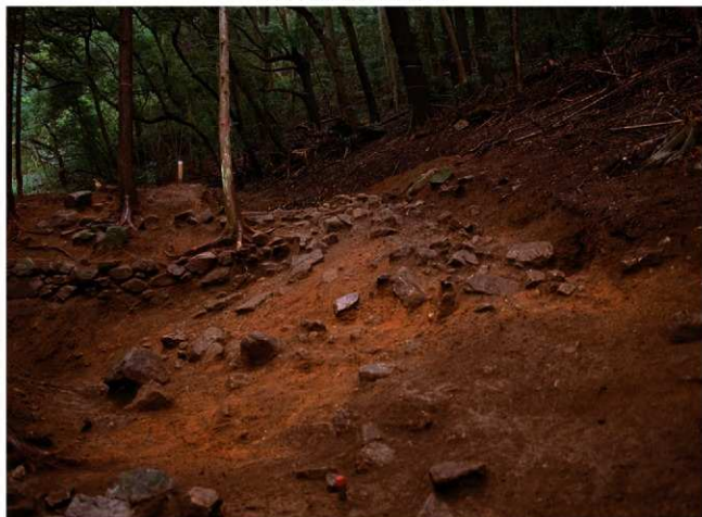
SF001 北側盛土除去後状況（南から）
