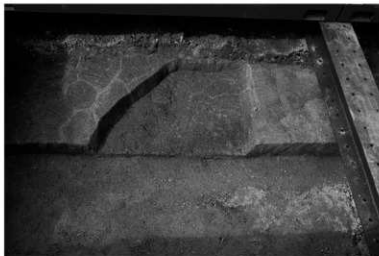
Pla1-5 国松9 6区完掘状況 (南から)
