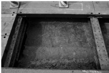
Pla1-1 国松9 3区完掘状況 (南から)
