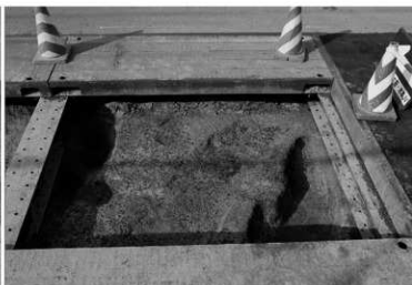
Pla3-4 国松9 28区完掘状況 (南から)
