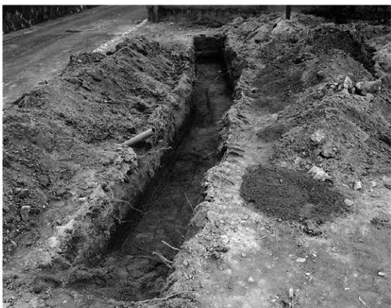
Plat13-2 尼18B トレンチ掘り下げ状況 (北から)
