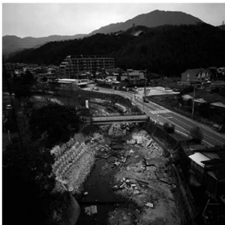
幸ノ元井堰第1次調査全景（西から）
