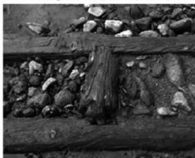
SX009 ⑤ 胴木南側支木 (東から)
