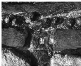
ホゾ穴状況(SX003g) (東から)
