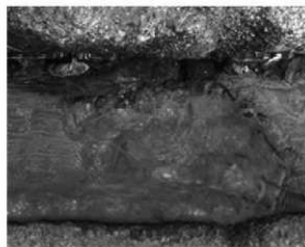
ホゾ穴状況 (SX002d) (西から)
