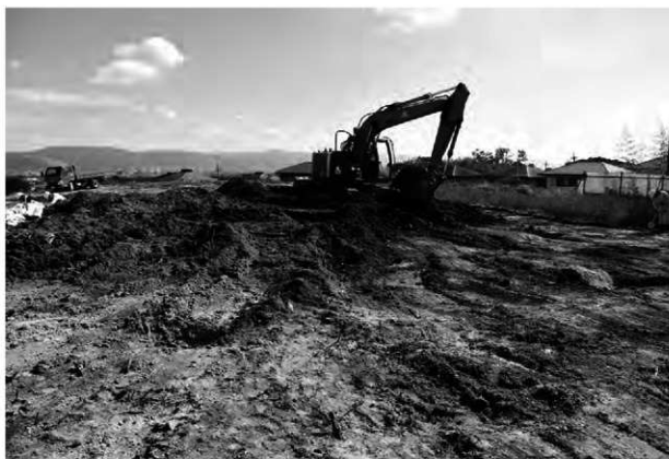
重機掘削状況 (西から)
