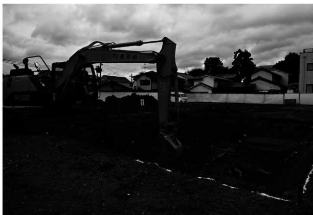
重機掘削状況（北東から）
