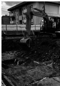
写真1 重機掘削作業
