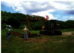
試掘坑の設定後、磁気探査を行い、 重機による掘削を開始する
