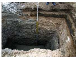
そー101ハ 掘削状況
