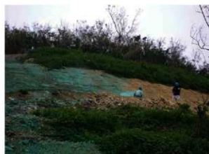
調査終了時には種子吹き付けによる 赤土流出防止対策を行う
