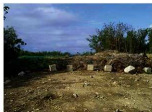
台風前には伐採樹木の飛散等を防止するために 対策を行った
