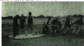
飛行場拡張の地均し作業『大祿の今昔』より
