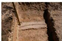
埋設物検出状況 (南から)
