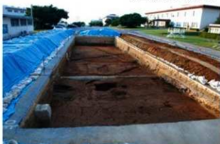
攪乱掘削後（東から）
