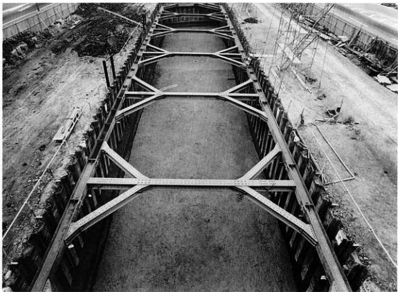
G トレンチ弥生時代第3遺構面全景
