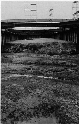
左-I トレンチNR4401左岸(南岸)
