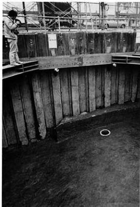
左-FトレンチPit 3101
