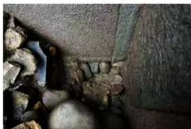
雑土蔵下石垣最下段・根固め栗石検出状況
