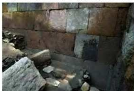
雑土蔵下石垣西面下部検出状況
