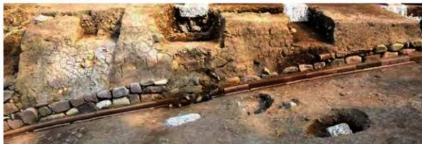
坂道法面の土留石積と土羽（北側）
