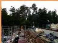
石垣の段ごとに写真測量を実施
