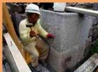
石材調整の状況を写真撮影
