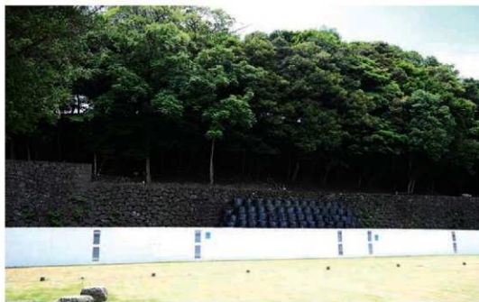
丸の内園地石垣の現況
