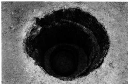
233SE045井戸枠詳細 (南から)
