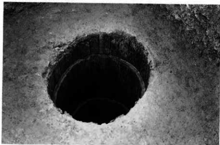
233SE035井戸枠詳細 (東から)
