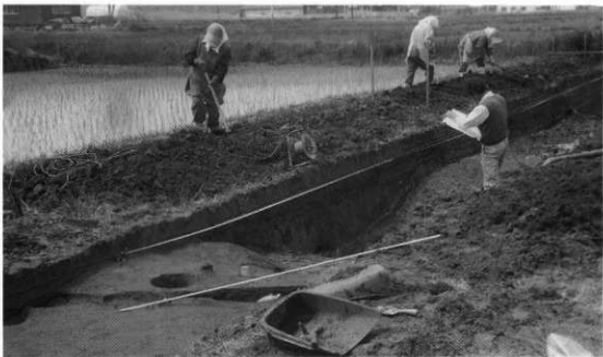
A区作業風景（東から）
