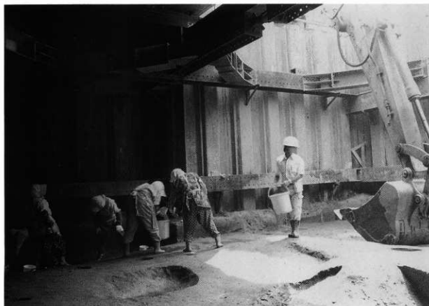
昭和60年度調査区排水作業（東から）
