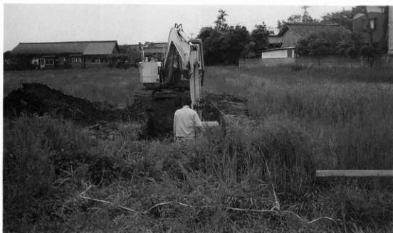
C区表土除去作業（北から）
