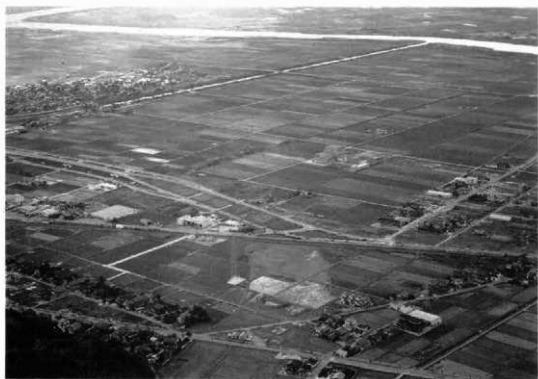
(2) 空からみた第2次調査区(東から)
