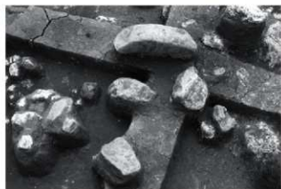
前庭部石材状況
