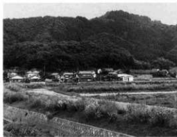
写真1 引地・引地下地区遠景
