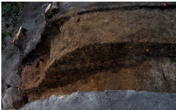
4 R2-4 トレンチ土壘断ち割り状況
