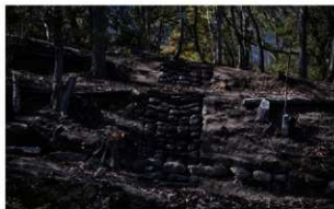
写真1-7 R2-4tr 埋め戻し状況 (表面は補生土のうで保護している)
