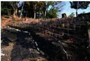
写真4-8 南西部城壁整備地点 (平成30年1月23日撮影)
