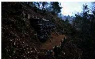
写真 4 - 24 南東部列石保護地点 2 段目整備状況 (平成 29 年 2 月 10 日撮影)
