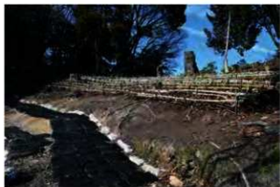
写真4-5 南西部城壁整備地点 平成28年度終了段階の状況 (平成29年2月28日撮影)
