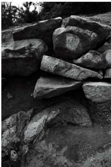
写真44 南東部石積み（東から）
