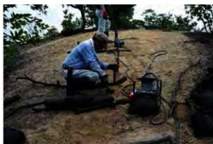
写真 4 - 36 山頂への散策路1 整備作業風景2 (平成 29 年 7 月 10 日撮影)
