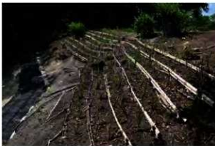
写真4-6 南西部城壁整備地点 チガヤ生育状況 (平成29年5月8日撮影)
