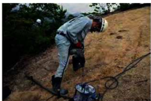
写真 4 - 35 山頂への散策路1 整備作業風景1 (平成 29 年 7 月 10 日撮影)
