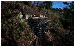
写真 4 - 22 南東部列石保護地点 1 段目整備状況 (平成 29 年 1 月 31 日撮影)
