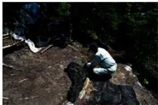
写真4-7 南西部城壁整備地点 植生土のう施工状況 (平成29年6月13日撮影)
