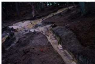
写真4-1 南西部城壁整備地点 調査当時の状況 (平成14年11月15日撮影)
