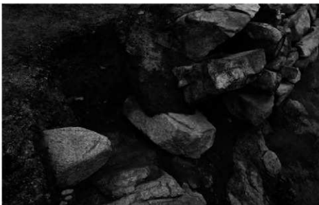
写真43 南東部石積み断面（南から）
