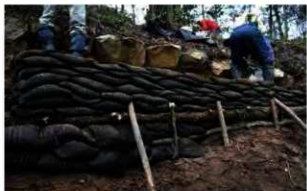
写真 4 - 21 南東部列石保護地点 1 段目整備作業状況 (平成 29 年 1 月 27 日撮影)
