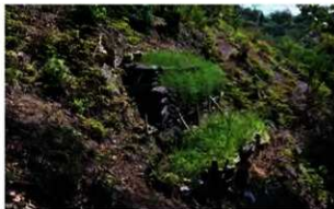
写真 4 - 26 南東部列石保護地点 整備後の経過 2 (平成 29 年 5 月 30 日撮影)
