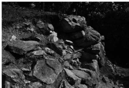
西部石積み 断面 (北から)
