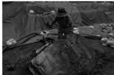
トレンチ内崩落石除去作業風景
