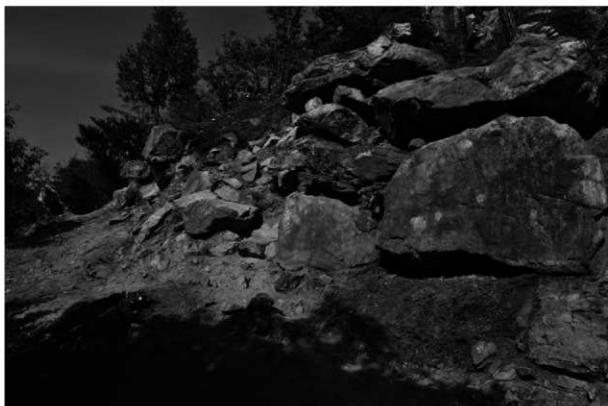
西部石積み 清掃後 (2) (南西から)
