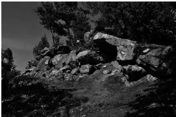
西部石積み 清掃後 (1) (南西から)
