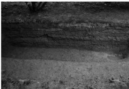
H20 - 2 トレンチ 北壁断面（南から）
