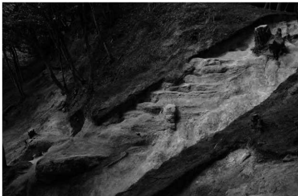
H19-1 トレンチ 西壁土塁残存状況（東から）
