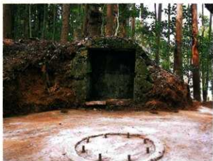
1号砲台跡 弾薬庫 東から
