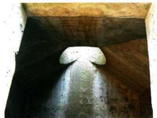
コンクリート造建物跡 内部天井 北西より
