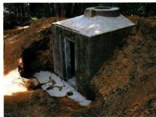
コンクリート造建物跡 入口 西より
