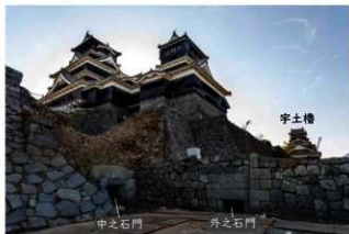
崩落石材回収後の石門（令和4年〔2022〕12月）
