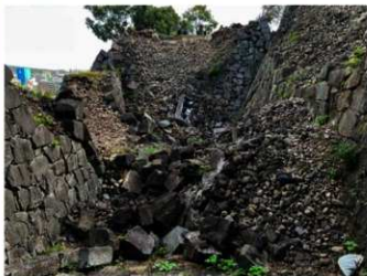
崩落した石材でふさがった石門入口（平成28年〔2016年〕4月）
