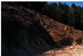
(107) 72地点調査前（南から）
