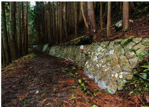
1 第2調査地点現況（東から）
