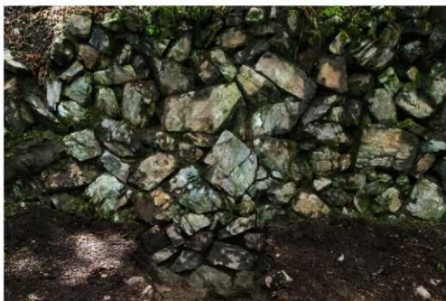
3 KT2法面石垣 検出状況 (南から)
