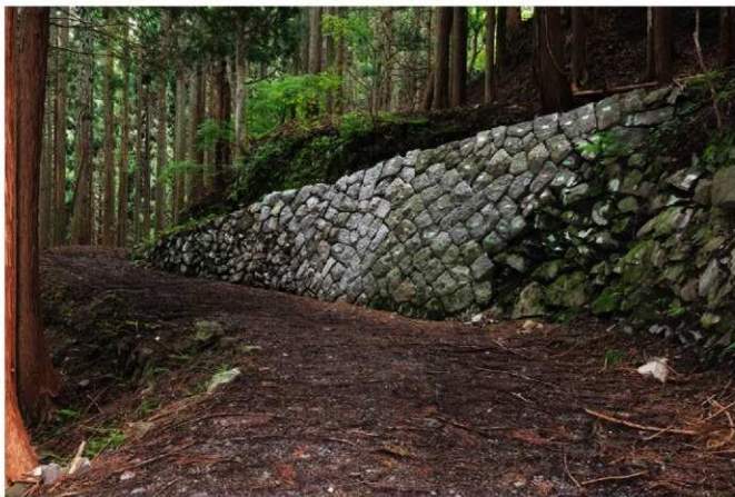
1 第4調査地点復旧状況（東から）
