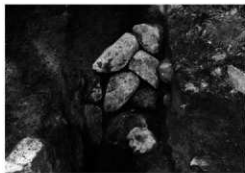
写真9 TT5法面石垣根石検出状況 （南から）
