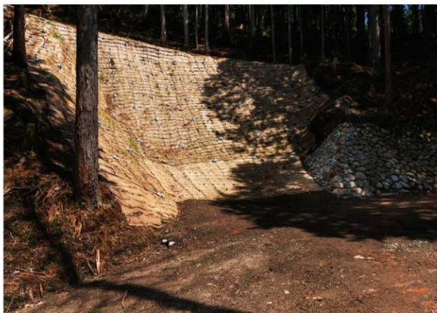
2 第5調査地点付近復旧状況（南西から）
