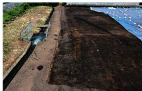
RG503・504 溝跡、堰跡 検出状況 (北西から)
