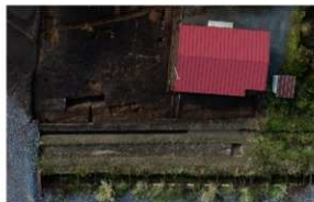
RG504 溝跡、堰跡 全景 (上が南西)
