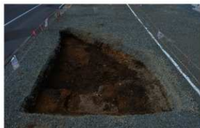
第4次調査Ⅱ区 調査区全景 (東から)
