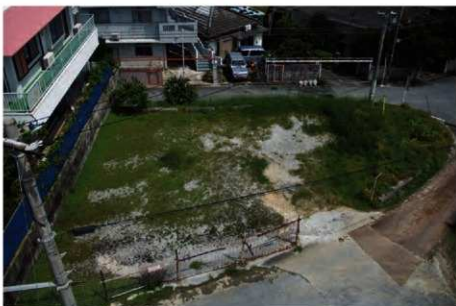
着手前 南東から
