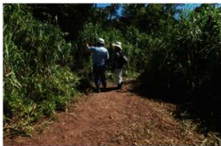
作業通路伐採確認
