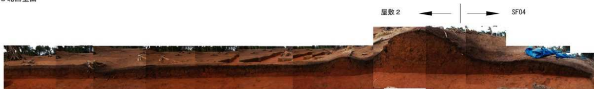
トレンチ3 北西壁面
