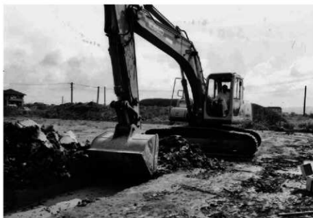
1. 重機による表土掘削
