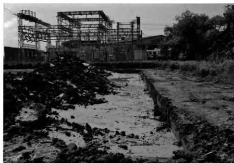
2. 西側表土掘削状況（北から）
