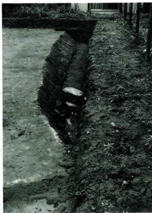
第 3 号溝南半部分
