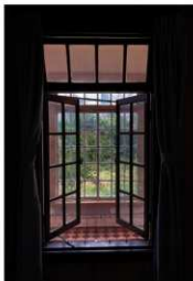
写真3 応接室の観音開きの窓
