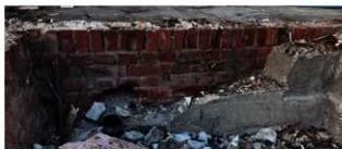
写真5 レンガに加えて分厚いコンクリートの基礎
