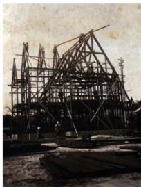
写真6 棟上げの写真(大正14年4月)
