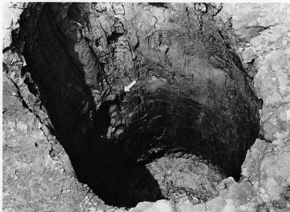
SE3006 木柱補修状況
