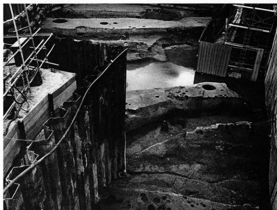
b. 同上 最終遺構面（北から）
