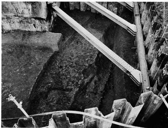
b. 同上 江戸時代の自然河川 全景（東から）
